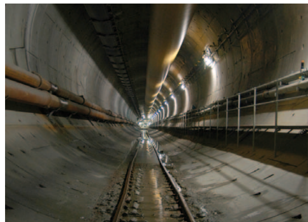
Eisenbahntunnel durch den Halland-Berggrücken in Schweden
